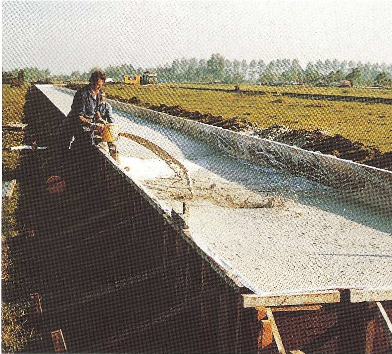
Aanleg van een fundering van schuimbeton in het 'moeras' van Boskoop
