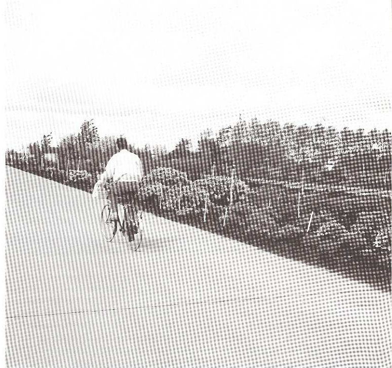
Ook de kavelpaden zijn op schuimbeton gefundeerd
