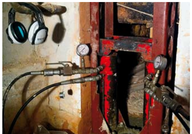
Plaatsing VDM-vijzelpaal in kruipruimte
