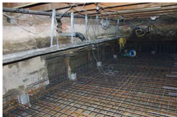
Onderkeldering in combinatie met VDM-vijzelpalen
